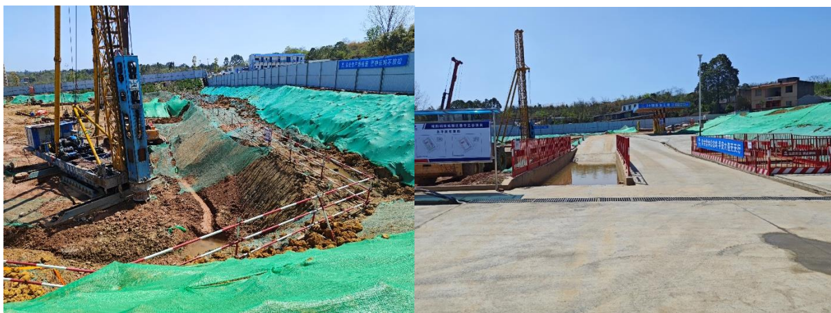
场地临时遮盖（2024.3）
