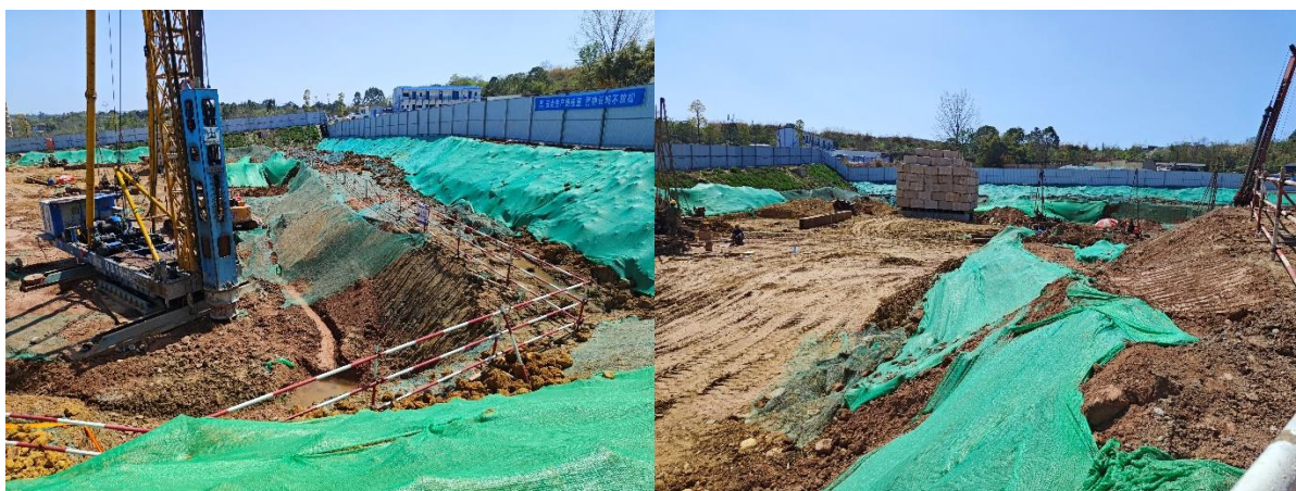
基坑临时遮盖（2024.2）
